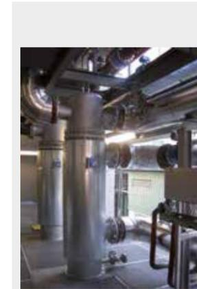
1 **Rohrbündel - Wärmetauscher**
