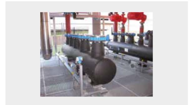
3 **Heißwasserverteiler aus Stahl**
